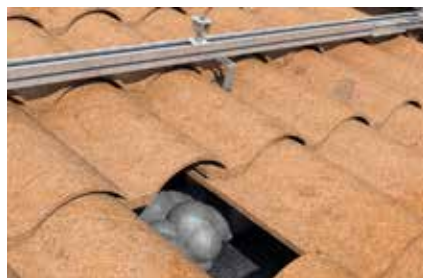
Fissaggio di tegole e coppi
